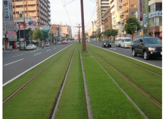
鹿児島市内の市電軌道敷緑化
